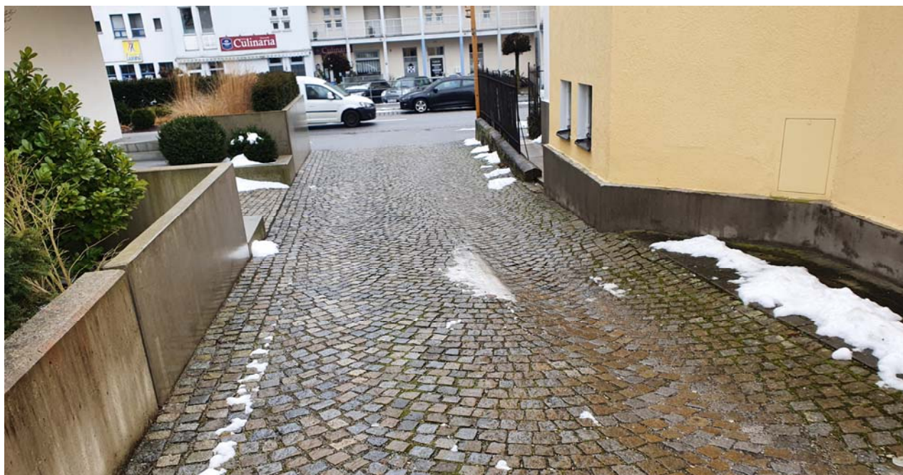
Foto 6: Bestehender Zufahrtsweg zum künftigen Bauvorhaben – Blick zur Regensburger Straße (PSLV, 02.2021)
