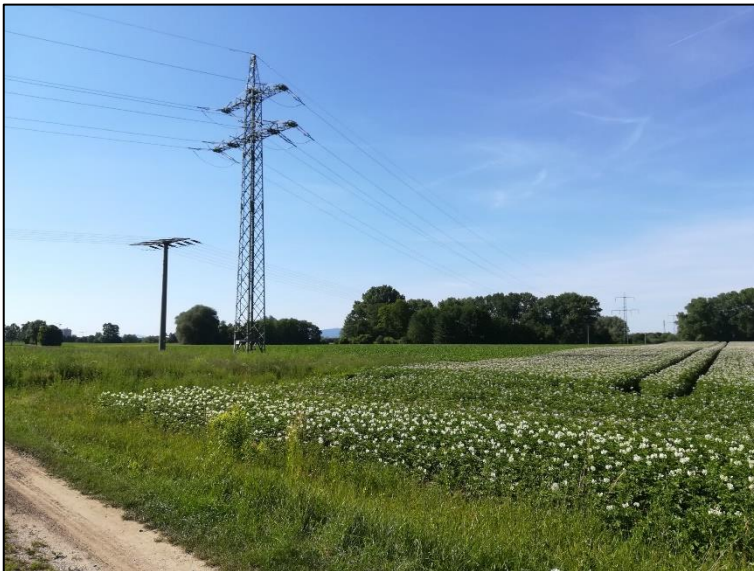
Blick von Südosten nach Norden auf das Plangebiet mit der 110-kV-Freileitung und der 20-kV-Doppel-Freileitung. Im Hintergrund Feldgehölze im Eglseer Moos.
